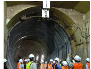
沈埋函とTBM接合点見学
