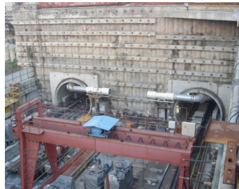
イェニカブ駅TBM2, 3号機発進基地
