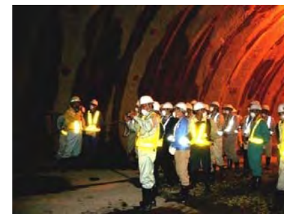
東工事切羽見学
