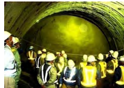
西工事切羽見学
