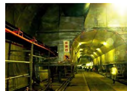
西工事ベルコン設備と覆工コンクリート養生
