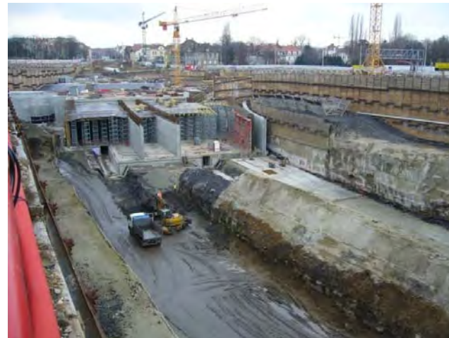
地上からトンネルへのアクセス工事（手前側トンネル）
