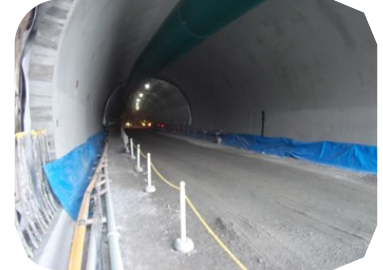
坑内安全通路、路盤
